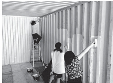
図21. コンテナを塗装している様子
